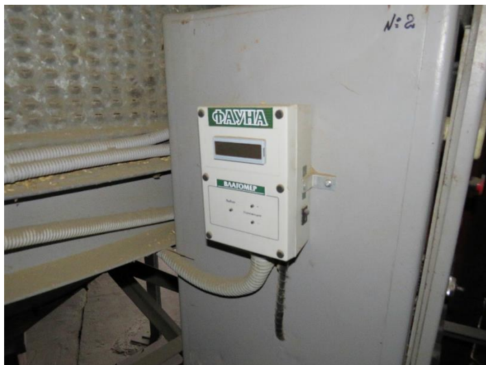
Рис. 1. Поточный влагомер зерна на пункте СПК «Кобраловский»
