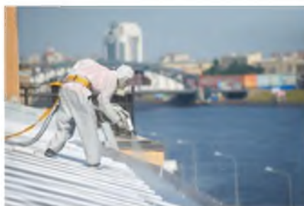
Рис. 2. Технология устройства покрытия из полимочевины
