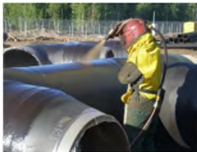
Рис. 1. Технология устройства покрытия из полимочевины
