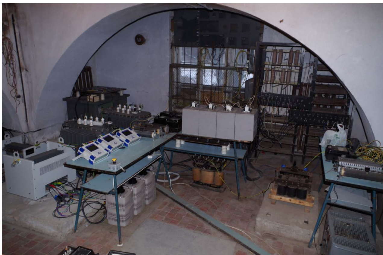
Рис. 4. Общий вид установки для исследования двухпроводной системы электропередачи трёхфазного тока с трансформаторными преобразователями числа фаз
