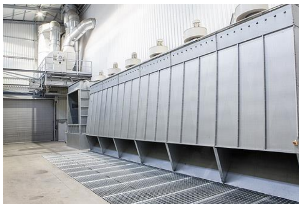
Рис. 4. Устройство обеспыливания завальной ямы фирмы PETCUS
