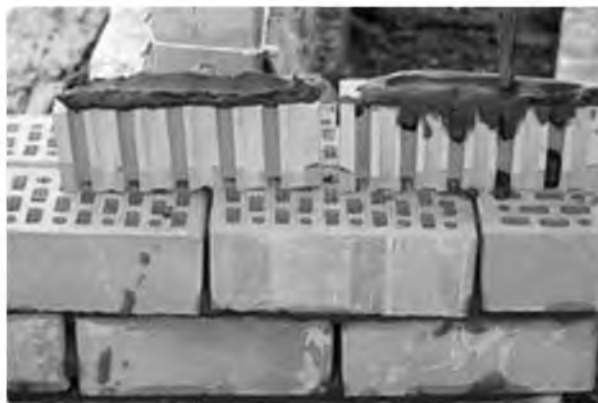
Рис.4. Заполнение технологических пустот
