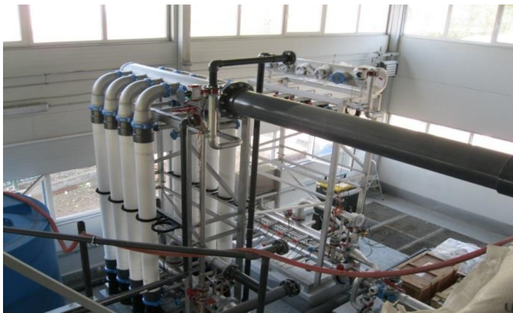
Рис. 3. Мембранный аппарат с половолоконными напорными ультрафильтрационными мембранами для разделения фаз очищенной воды и активного ила
