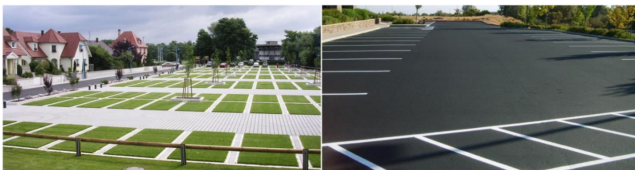
Рис. 4. Сравнение внешнего вида зелёной парковки и парковки из асфальтобетонного покрытия
