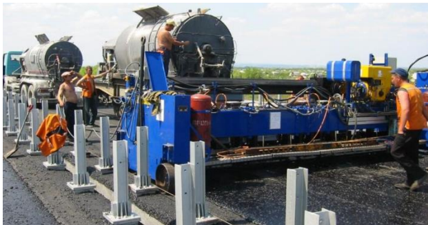
Рис. 3. Устройство дорожного покрытия из литого асфальтобетона
