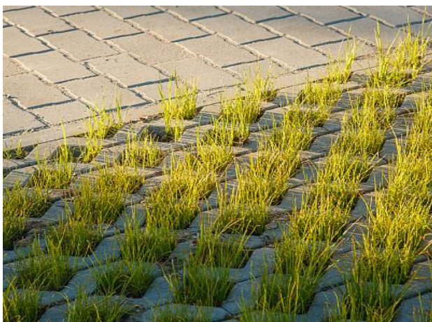
Рис. 5. Газонная решётка с газоном около пешеходного тротуара [3]
