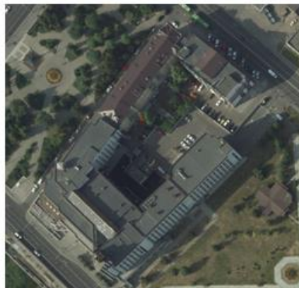
Рис. 3. Стереопара, на которой виден закрытый фундамент дома
