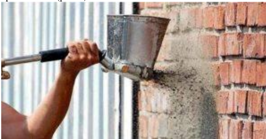
Рис.4. Нанесение силиконовой штукатурки механизированным способом
