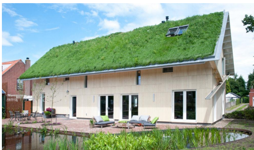
Рис. 1. Общий вид «зеленой» крыши
