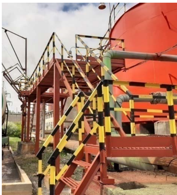
Рис. 5. Типовая эстакада с откидным мостиком
