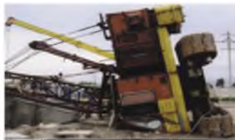
Рис. 1. Авария гусеничного грузоподъемного крана в результате опрокидывания
