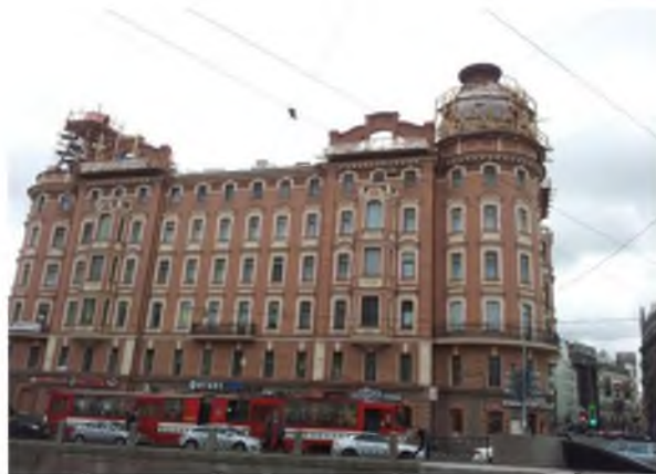
Рис .1. Общий вид здания со стороны наб. Карповки
