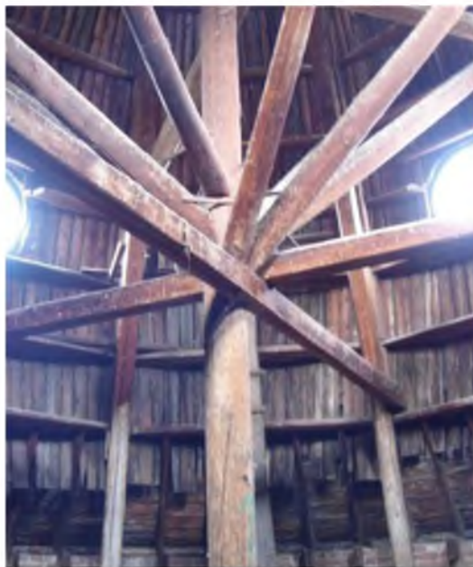
Рис.3. Общий вид существующего узла стыковки элементов
