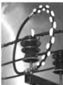
Рис. 5. Общий вид петлевого модифицированного разрядника РДИП1-10 [3]
