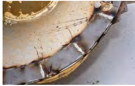
Рис. 3. Окончательное приваривание накладок
