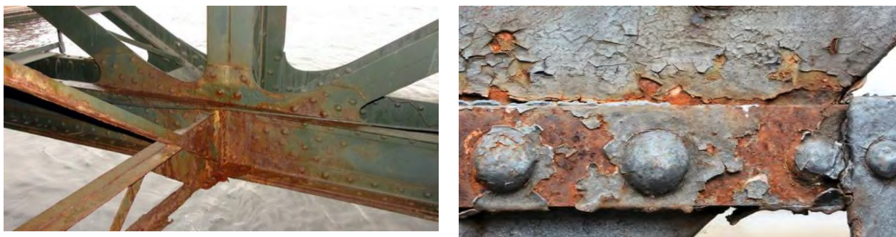
Рис. 3. Химическая коррозия
