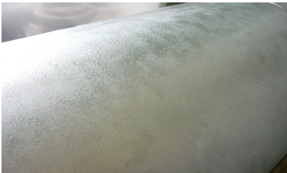
Рис. 6. Конденсация влаги на наружную поверхность воздухоосушителя
