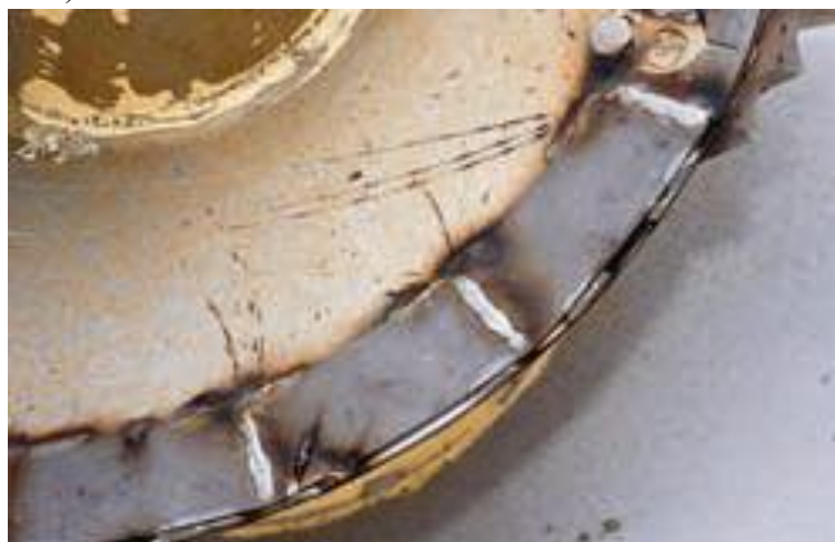
Рисунок 5. Окончательное приваривание накладок Figure 5. Final welding of overlays
