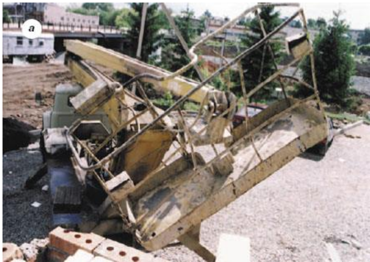
Рисунок 1. Последствия падения люльки на площадку лестничного марша Figure 1. The consequences of the cradle fall to the landing of the flight of stairs
