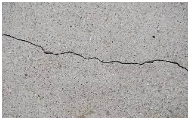
Рис. 1. Растрескивание бетона
