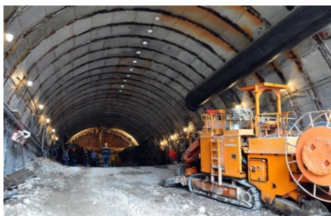
Рис. 4. Подземное строительство из монолитного бетона
