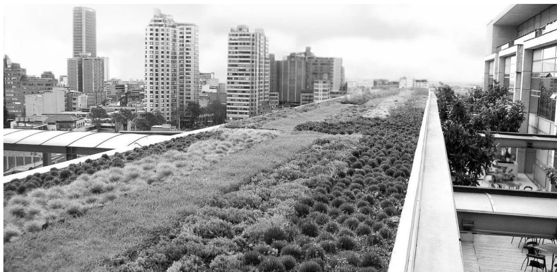
Рис. 2. Пример устройства экстенсивной крыши
